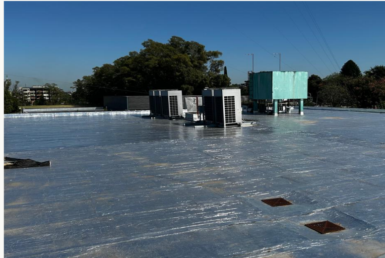
Reparación de cubierta en el Edificio Dorrego
